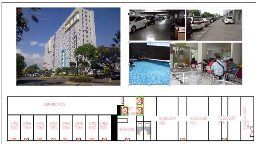
Gambar 6. Tampak Depan, Denah Lantai 1 dan Fasilitas Penunjang di Lantai 1 Apartemen Purimas Sumber: Hasil Observasi (2016)
