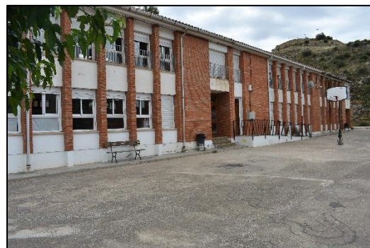
Ilustración 5. Edificio y patio de Educación Primaria. Fuente: elaboración propia.
