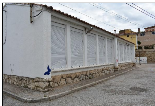
Ilustración 2. Edificio de Educación Infantil. Fuente: elaboración propia.
