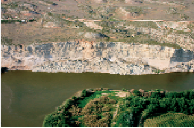
Figura 9. Acumulación de bloques (Rock falls) producidos por el descalce erosivo del río Ebro cerca de la localidad de Alagón. Fotografía: Francisco Gutiérrez.
