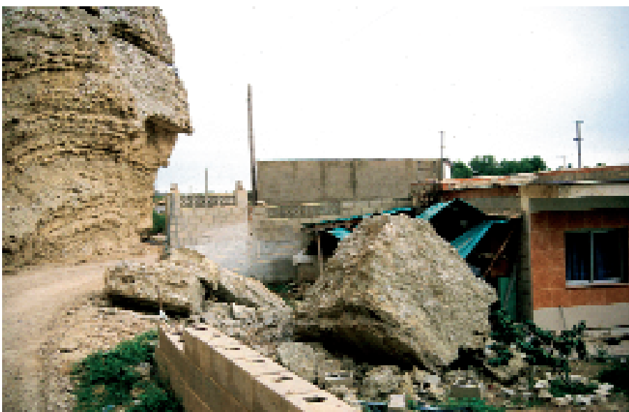
Figura 10. Bloque (rock fall) caído del escarpe sobre una vivienda en las proximidades de Juslibol. Fotografía: Francisco Gutiérrez.
