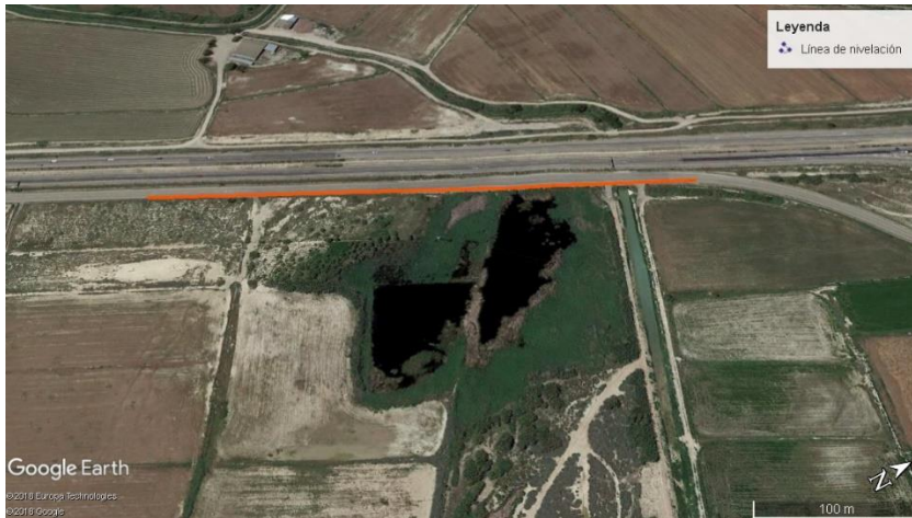
Figura 10: Línea en la que se realizó la nivelación en la Dolina de Zuera marcada en color naranja. Se emplaza en la N-330 y tiene una longitud de 450m.
