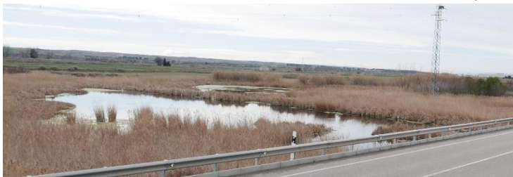
Figura 1: Dolina de Zuera, también llamada " La Balsa". Está formada por dos masas de agua y se encuentra junto a la N-330. Es una dolina activa y el hundimiento afecta a dicha infraestructura lineal y a la autovía contigua, la A-23.
