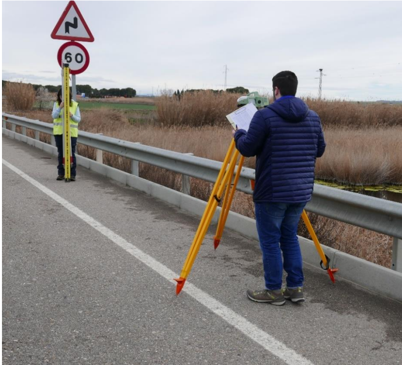
Figura 12:A la derecha se observa el nivel digital (Leica DNA03) al margen de la carretera N-330 realizando una medición empleando la barra codificada que se encuentra a la izquierda de la imagen, situada verticalmente sobre un clavo.
