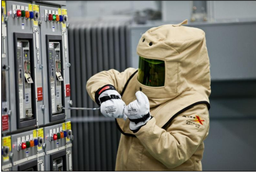
Figura 3: EPI contra el riesgo por arco eléctrico en una instalación eléctrica [11]
