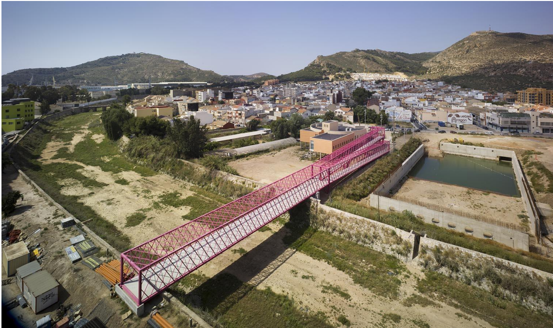
Figura 2: Pasarela peatonal situada en la Rambla de Benipila, Cartagena (Murcia). Construida en 2011, posee una longitud de 182 metros.
