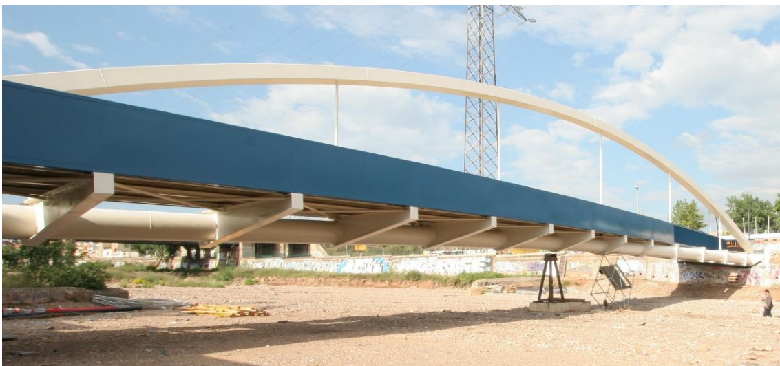
Figura 10: Pasarela de la Amistad, situada en Terrassa (Barcelona), cuenta con 56 metros de luz.
