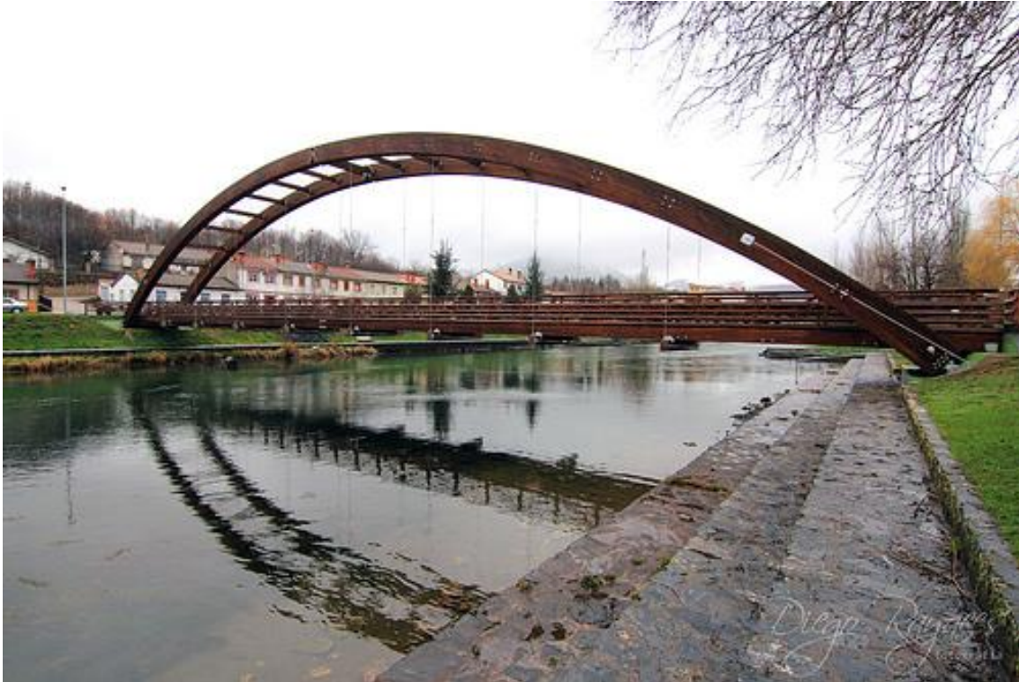
Figura 1: Pasarela de madera situada en Velilla del Río Carrión (Palencia), de 53 metros de longitud.
