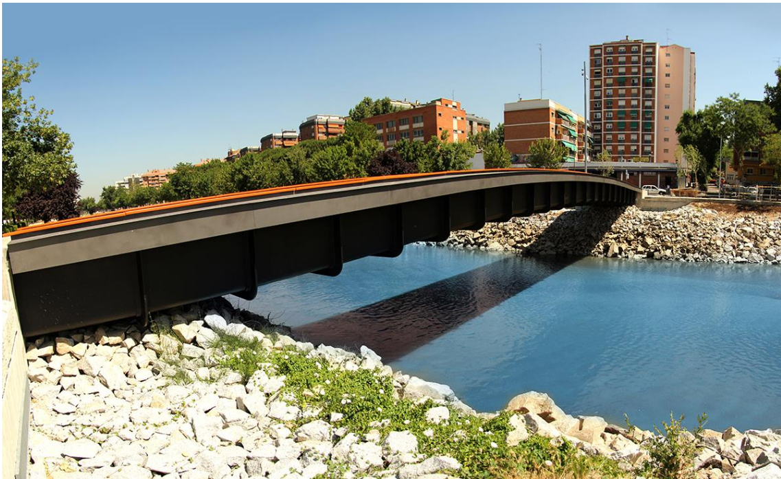
Figura 6: Pasarela de almuñecar. Forma parte de la actuación “Madrid Río Manzanares”, ubicada entre la M-30 y el puente de los franceses, en Madrid. La pasarela es una viga artesa en forma de U construida con un material composite reforzado con fibras, fibras de carbono con una matriz de resina polimérica. Posee una longitud de 43 metros, un ancho de 5 y un canto de 1,2.
