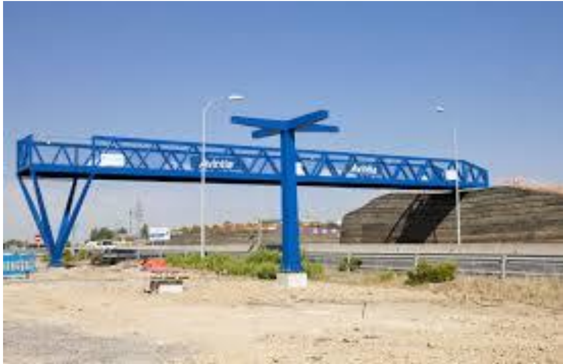
Figura 9: Pasarela situada en Leganés (Madrid), con una longitud de 40 metros, 4 metros de anchura y 50 toneladas de peso.
