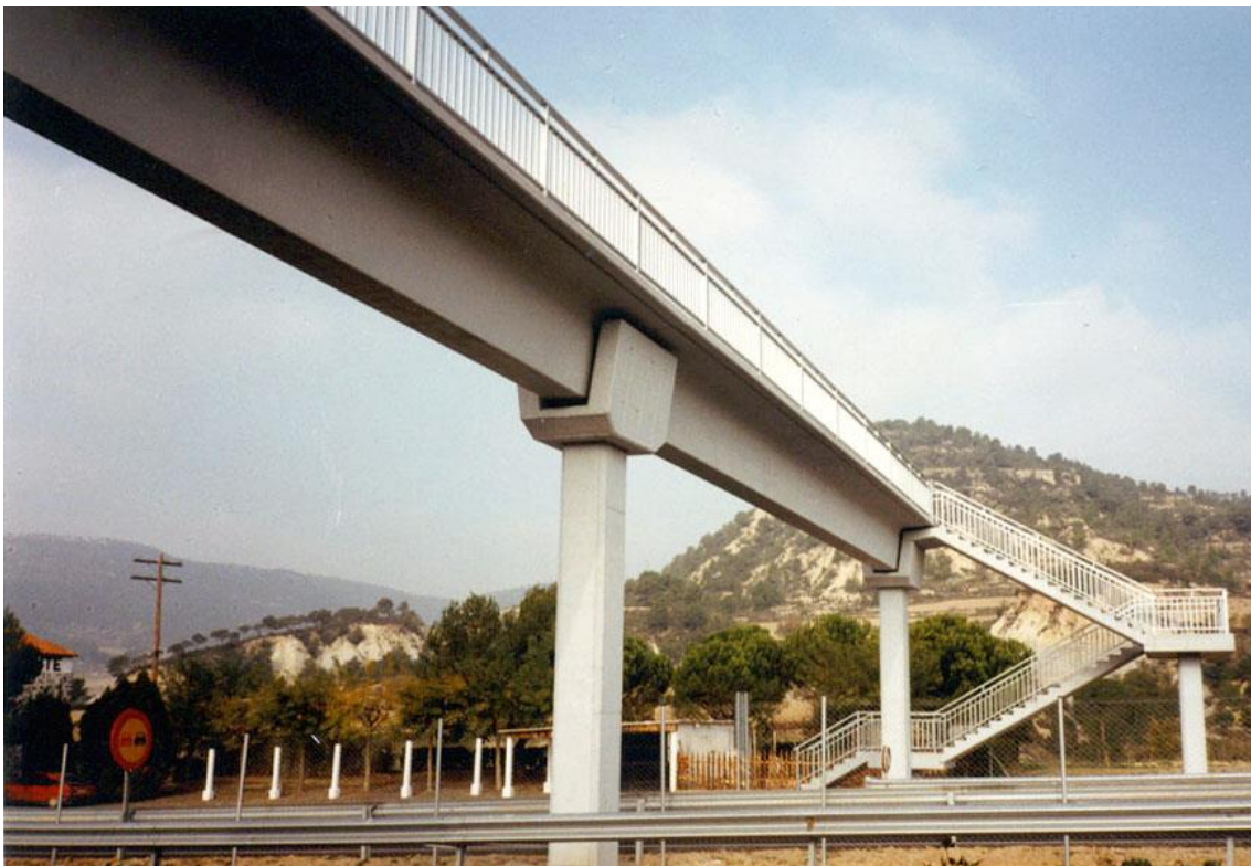
Figura 5: Pasarela situada en una autovía española.
