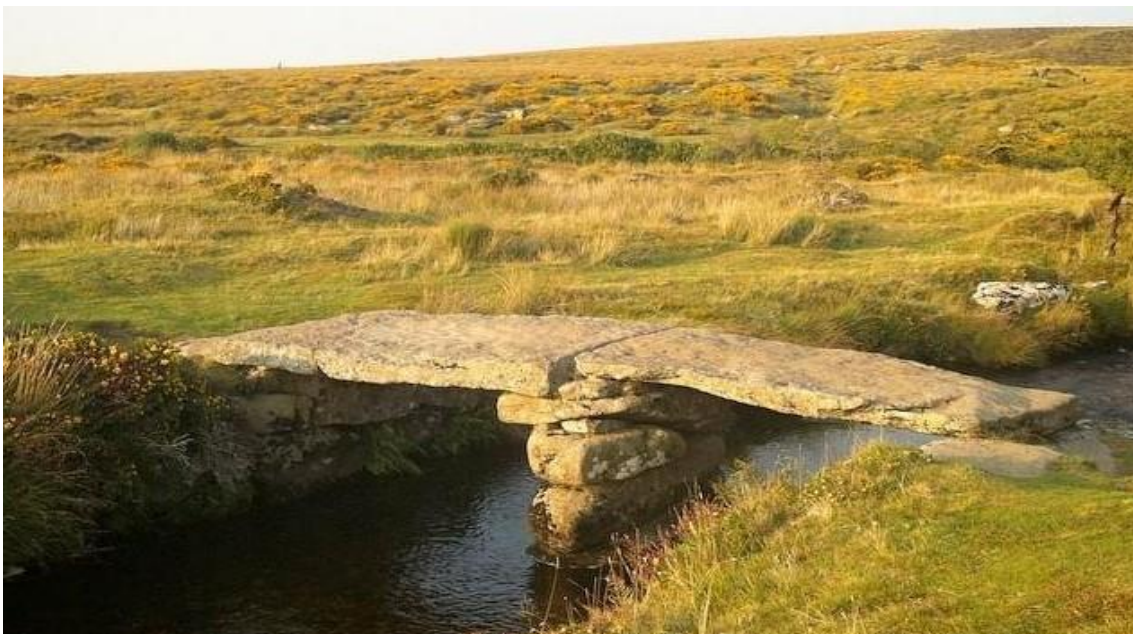
Figura 3: Puente de losas de Scorhill, en el Parque Nacional de Exmoor (Reino Unido). De origen medieval y todavía en uso, su construcción sobre un único pilar y con doble losa proporciona un paso muy útil sobre el río North Teign.
