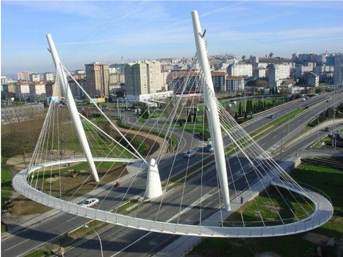
Figura 11: Pasarela atirantada La Rosa (La Coruña). Posee un tablero metálico con planta oval, de 156 metros de desarrollo y una anchura de tablero de 3 metros.
