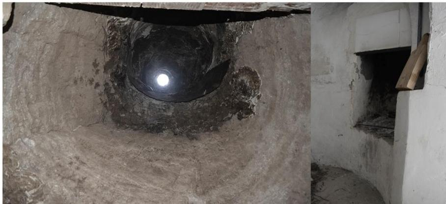
35. Conducto de vaciado y boca hacia la pisadera
