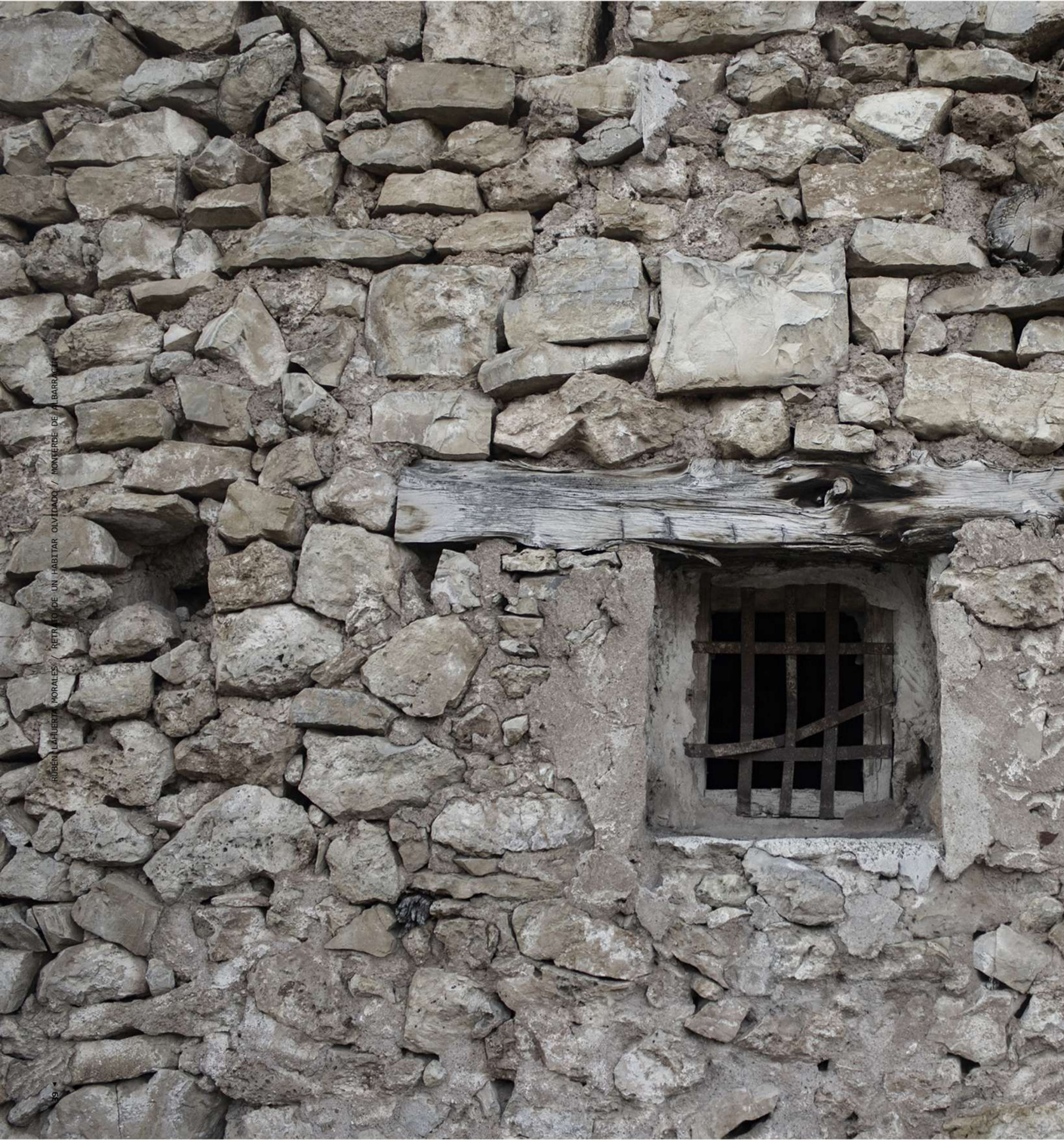
Fig 30./ Fachada de piedra, ventana con dintel de madera de sabina, Monterde de Albarracín. Construcción vernacula.
