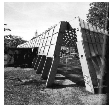
Figura 2.2.8 Imagen exterior del pabellón terminado.
