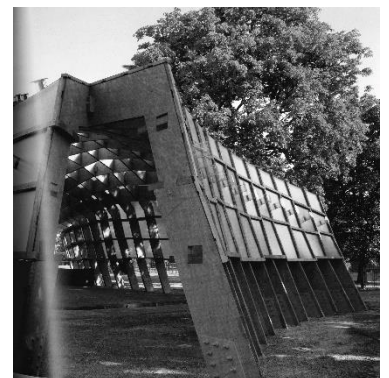
Figura 2.2.9. Imagen exterior del pabellón terminado.
