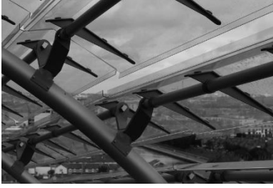
Figura 2.1.13. Detalle de los paneles de la envolvente exterior.
