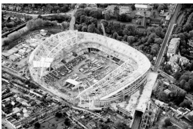
Figura 2.1.11. Construcción del estadio.
