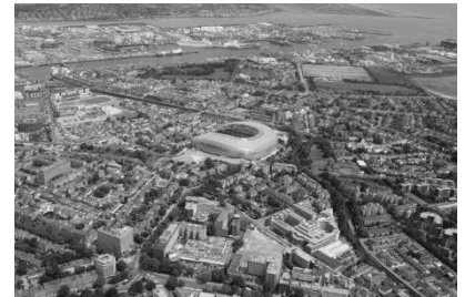
Figura 2.1.3. Vista panorámica de la ubicación del Aviva Stadium.
