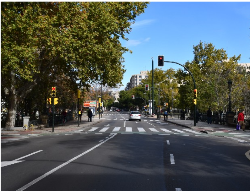
Fig 5.24. Avenida y puente de América.
