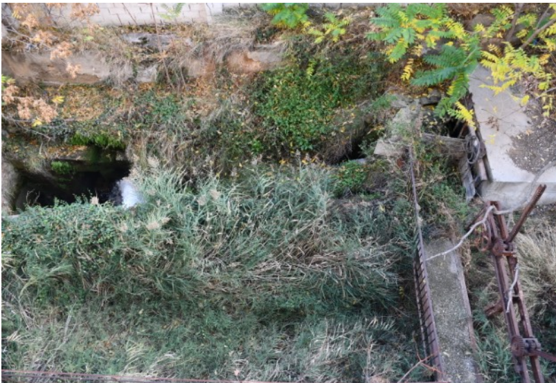
Fig 5.10. Acequia del Plano en su paso por la harinera..
