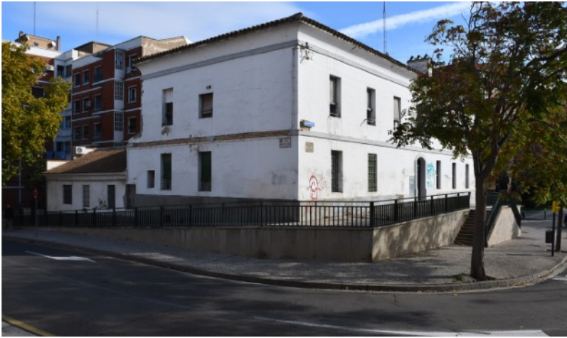
Fig 5.15. Edificio de horno desde calle Barón de Lalinde
