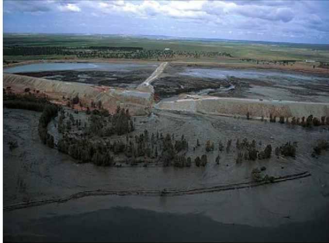
Fig. 1.2: Vista de la rotura producida en el dique de la balsa de Aznalcóllar [4].
