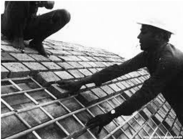
Imagen nº02 y nº03. Construcción de la cubierta ondulada con las piezas en retícula y el armado homogéneo ([02])
