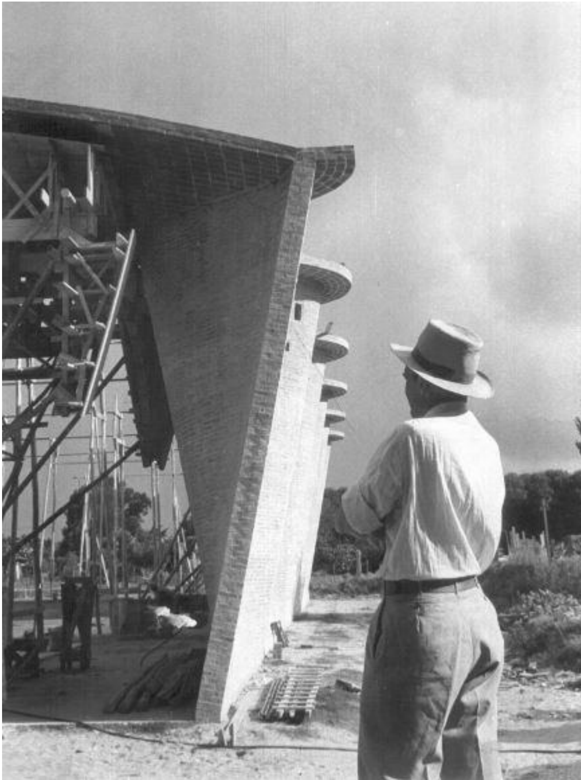
Imagen nº06. Eladio Dieste frente a la Iglesia de Cristo Obrero en construcción, a fines de 1959. Fotografía de M. Sassón. Archivo privado de la empresa Dieste-Montañez.
