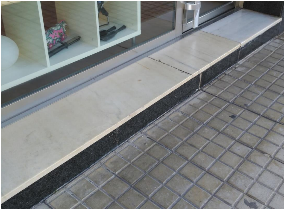
Figura 3: Acceso a una peluquería.
