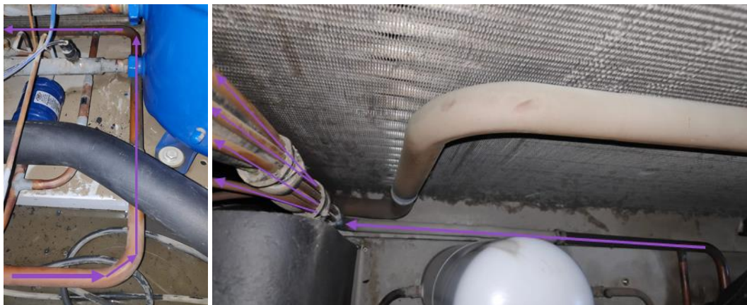
Figura 61: Entrada del refrigerante al intercambiador exterior modo calor.
