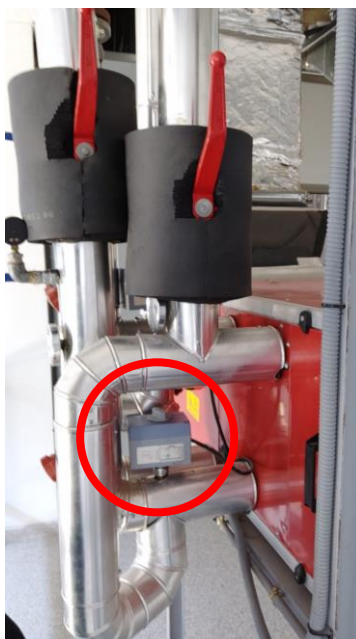
Figura 68: Conducto de entrada de la UTA.
