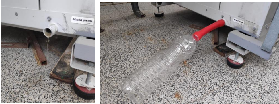
Figura 73: Instalación de un desagüe en la bomba de calor.
