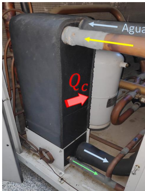
Figura 56: Intercambiador interior en modo calor.
