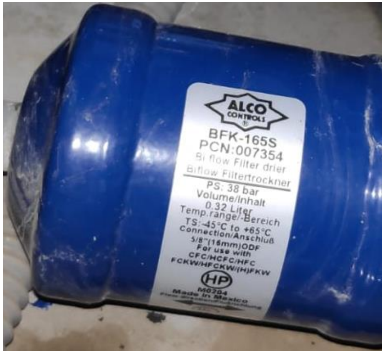
Figura 48: Etiqueta del filtro deshidratador de la bomba de calor.
