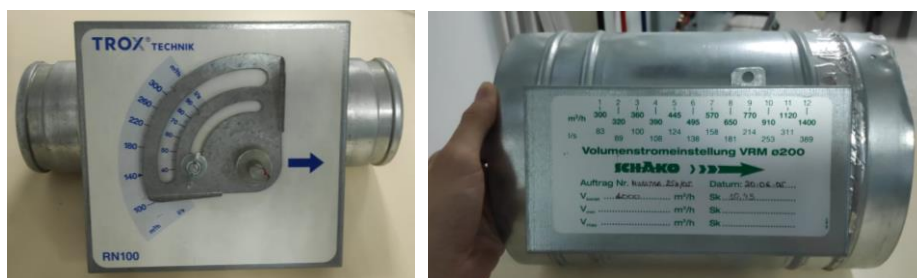
Figura 70: Compuertas de regulación.
