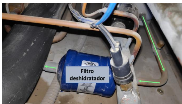
Figura 59: Paso del refrigerante por el filtro deshidratador en modo calor.
