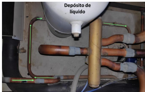
Figura 58: Paso del refrigerante por el depósito de líquido en modo calor.
