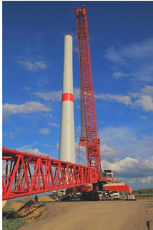
Ilustración 9: Izado mástil aerogenerador. Fuente: Pixabay
