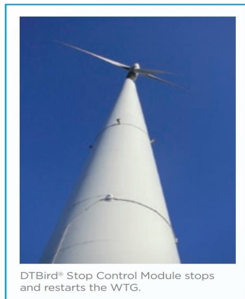
Ilustración 20: Sistema de paro de aerogenerador por colisión aves. Fuente: Web DTBird
