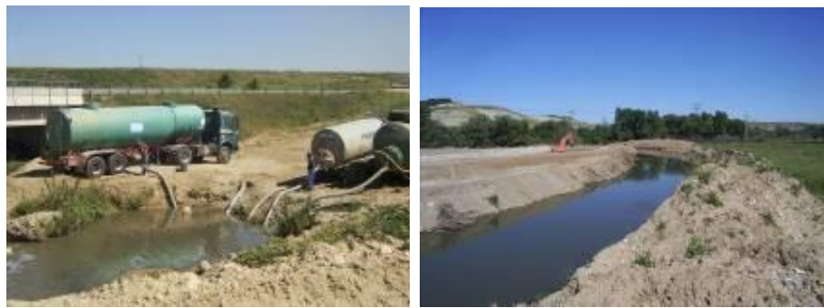
Ilustración 42: Carga de cubas para riego, Acuífero cercano obras. Fuente: Elaboración propia
