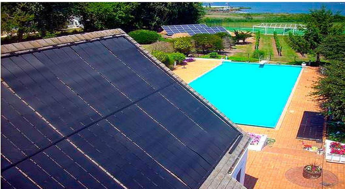
*Ilustración 1. Ejemplo de instalación de captadores solares en una piscina exterior particular.*
