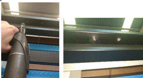
Figura 33: Remachadora y remache torcido.
