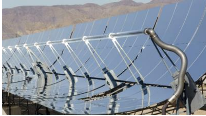
Figura 6.1. Captadores Siemens SunField 6 [19]
