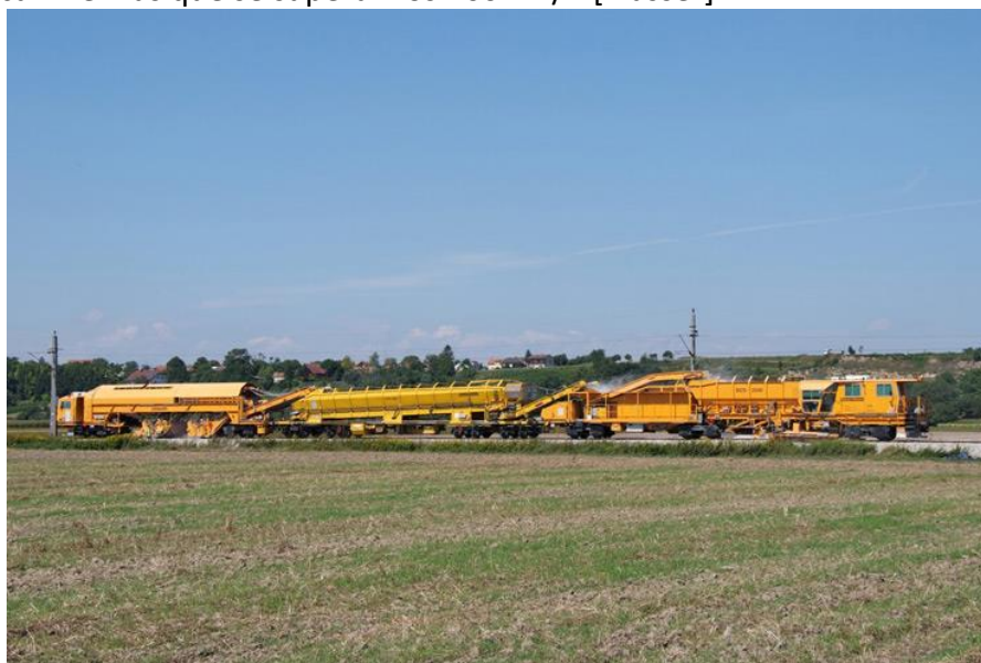
Figura 2. Vehículo pesado para el mantenimiento del balasto, con tolva de 15m 3 [Plasser].
