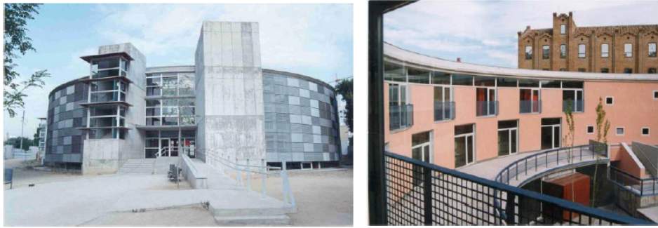
FIGURA 3 (a la izquierda): imagen externa de la estructura del edificio del ISE
