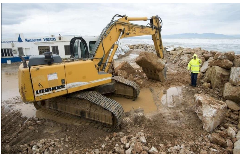
Figura 3: Dique de contención que se tuvo que construir con rocas para frenar el avance del mar y proteger el terreno (señalado con la flecha roja en la Figura 2) de la fuerza con la que el agua impacta.
