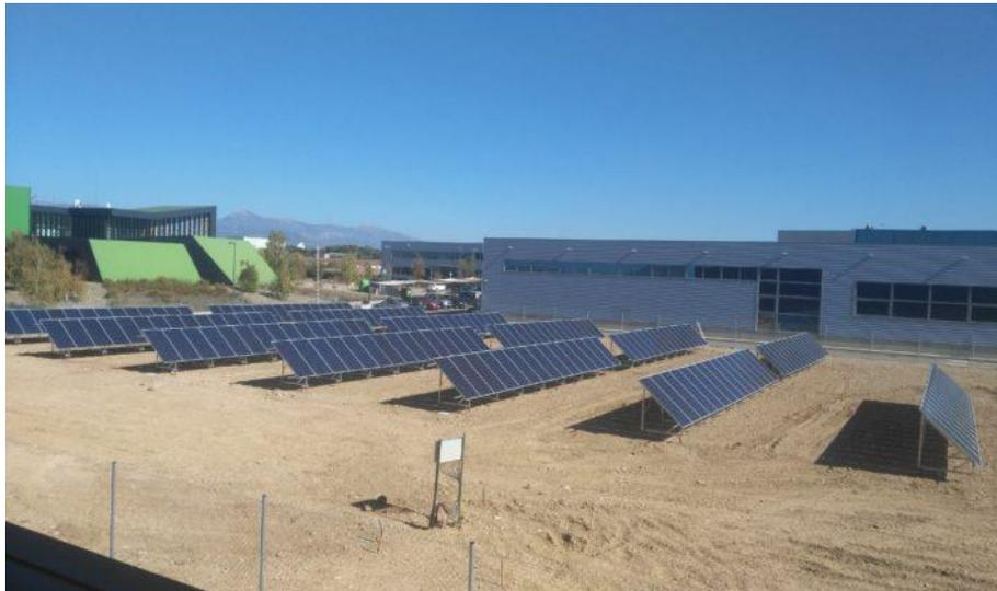
**Ilustración 3.** Instalación fotovoltaica aislada. Fuente: Fundación Hidrógeno Aragón.
