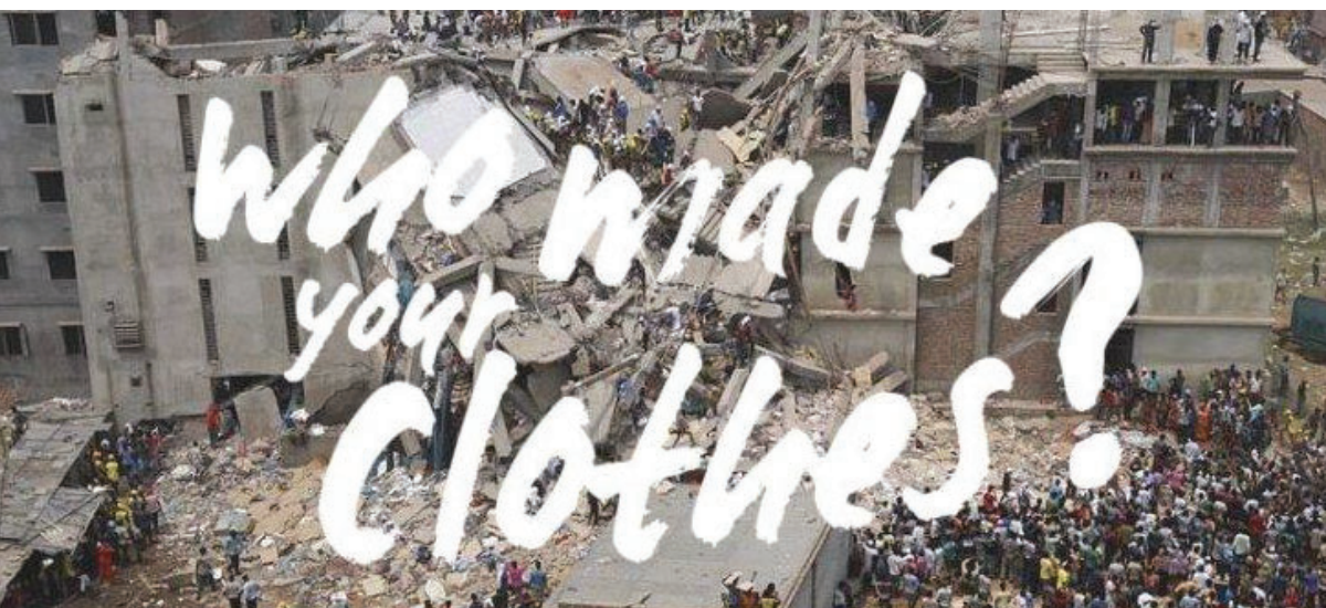
FIGURA 3 Colapso del Rana Plaza
