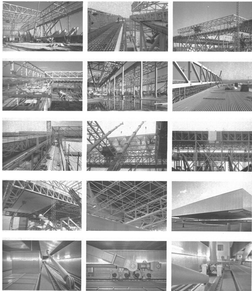
Ilustración 51: Proceso constructivo de la cubierta.
