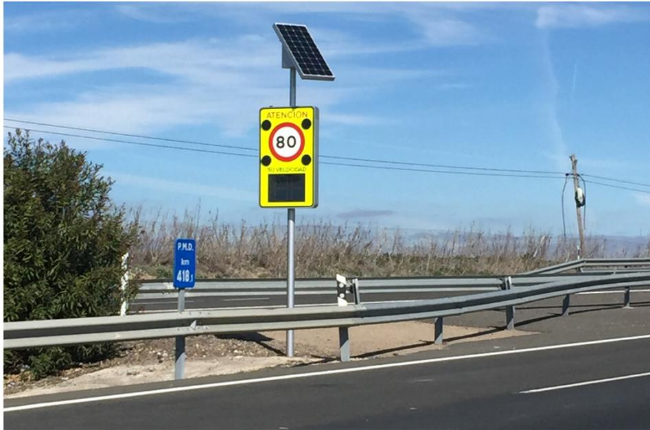
Figura 3: señal de tráfico con panel solar aislada de la red.
