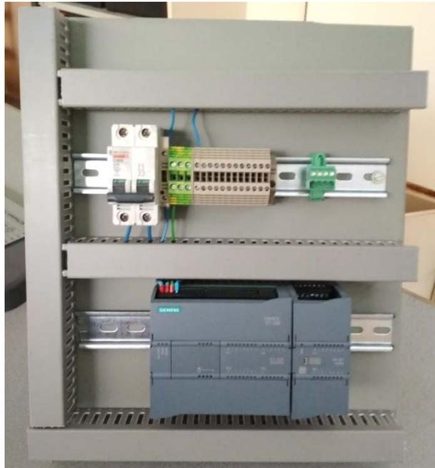
Comenzamos a cablear el automático según las instrucciones dadas por el fabricante, comenzando primero con el cableado eléctrico y posteriormente añadiendo todos los cables de señal. En primer lugar, cableamos las 3 tierras, luego el resto de los cables que van entre los componentes, finalmente metemos los dos cables Syslink siguiendo el código que viene en estos cables para llevarlas a las diferentes entradas y salidas del automático y su módulo de ampliación.
