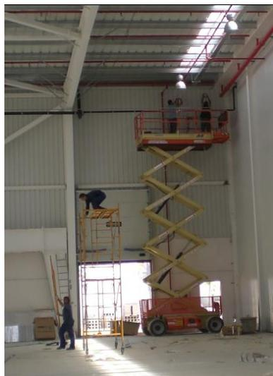
*Figura 30. Usos diferentes de andamio y plataforma elevadora*
