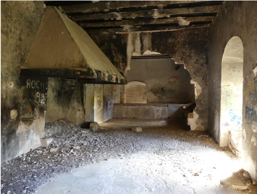
Figura 11. Interior del complejo conventual. Refectorio. Autor Esther Trallero. Abril de 2018.
