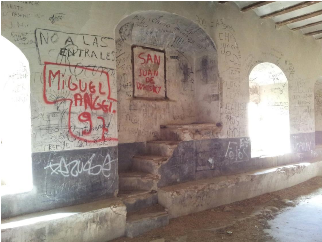
Figura 12. Interior del complejo conventual. Refectorio. Autor Esther Trallero. Abril de 2018.
