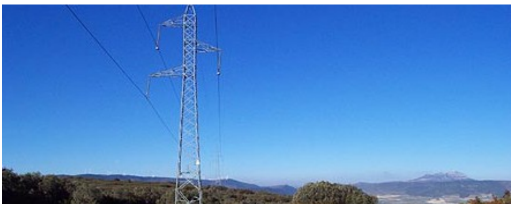
Figura 39. Poste de alta tensión en los alrededores de la Foz. Autor: Sanz Domeño (2018).
