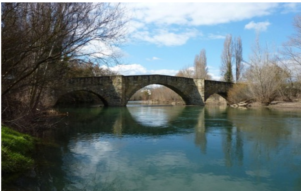
Figura 29. Puente de Sielva. Autor: Sanz Domeño
