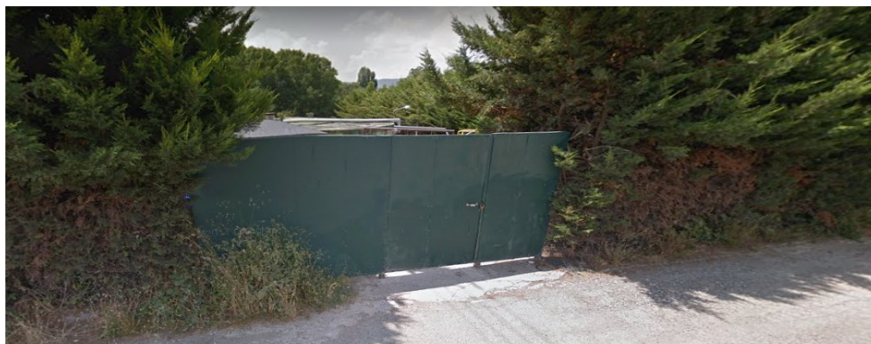
Figura 44. Imagen de la Depuradora de Agua de Lumbier. Autor: Sanz Domeño.
