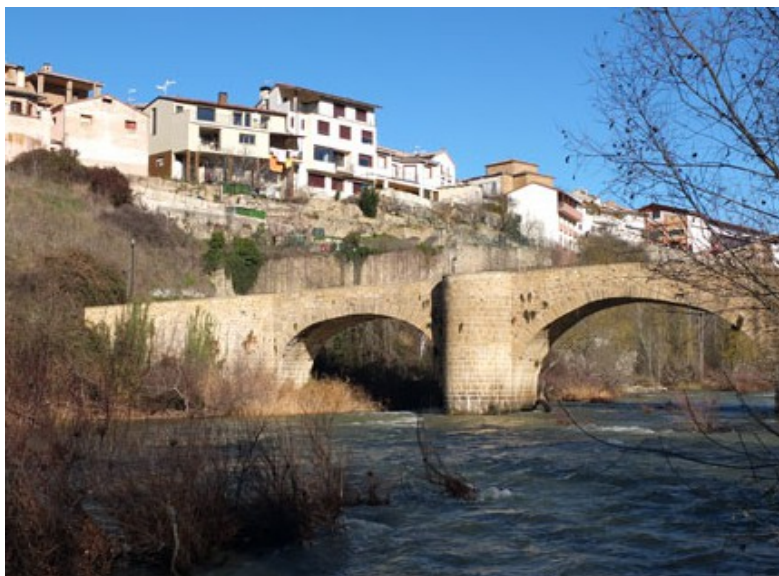
Figura 55. Imagen del Puente de las Cabras ya restaurado. Autor: Sanz Domeño.
