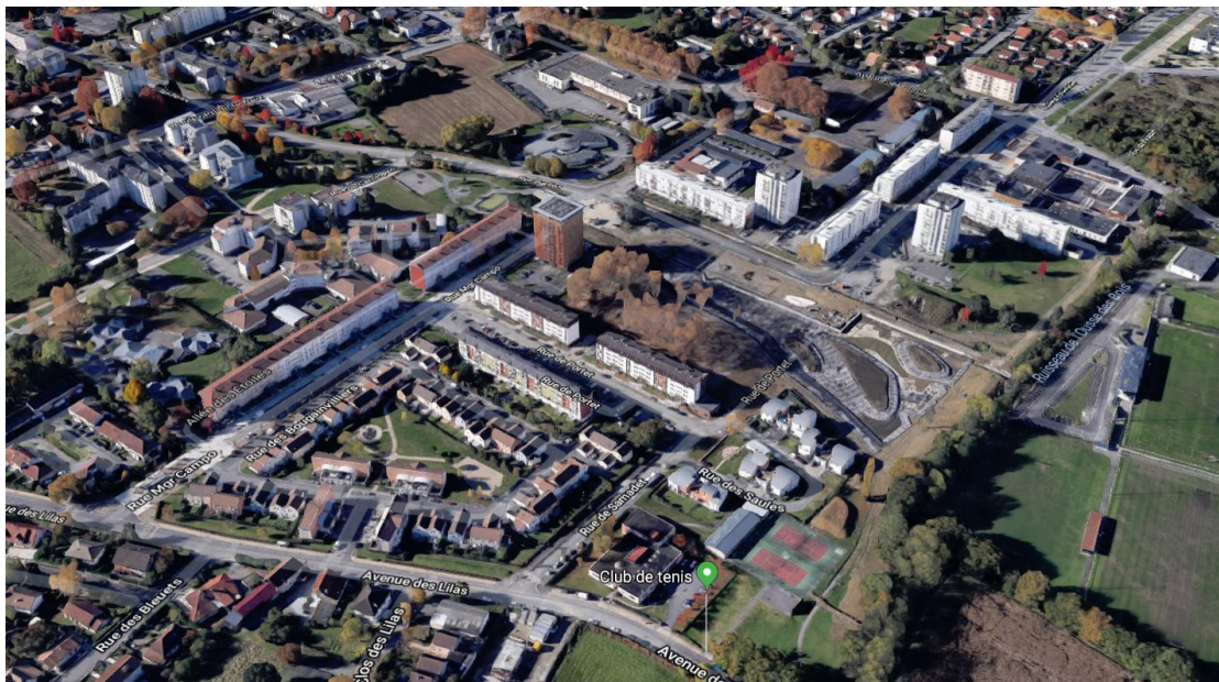
Fig. 14: Le Hameau en la actualidad. Se observa la desaparición de los inmuebles que inicialmente se situaban en la parte superior izquierda de la imagen y su sustitución por viviendas unifamiliares, fruto de un ambicioso plan de renovación urbana. Fuente: Google Earth, 2017
