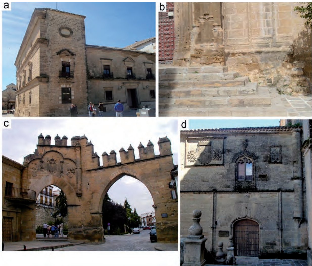
Figura 5. Algunos ejemplos de deterioros observados: a) Colonización biológica en la cornisa y en la zona de la bajante, en el Ayuntamiento de Úbeda; b) Deterioro del exterior de la iglesia de San Pablo (Úbeda) en el que se observa un fuerte proceso de arenización y/o erosión alveolar y eflorescencias; c) Puerta de Jaén y Arco de Villalar (Baeza), donde destaca la presencia de costras negras; d) Catedral de Baeza, donde se observa gran cantidad de colonización biológica, eflorescencias y costras negras, entre otros deterioros.
