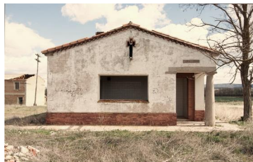
Figura 10. Estación de Caminreal. Edificio secundario de Aseos. Acceso aseos caballeros (Fuente: Colección autora, 2017)
