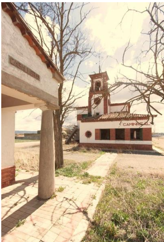
Figura 9. Estación de Caminreal. Vista lateral desde el edificio secundario de aseos. (Fuente: Colección autora, 2017)
