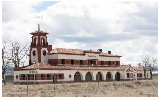
Figura 13. Estación de Caminreal. Vista de la torre desde las vías, vista noroeste (Fuente: Colección autora, 2017)
