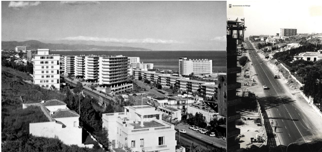
Figura 6. Izquierda: La N-340 a la altura del complejo Eurosol-Euomar, Torremolinos. Derecha: La N-340 desde las obras de Eurosol-Euomar, 1963 (Fuente derecha: sig. 23 – Sin especificar – 188 – 111, Archivo Municipal de Málaga)
