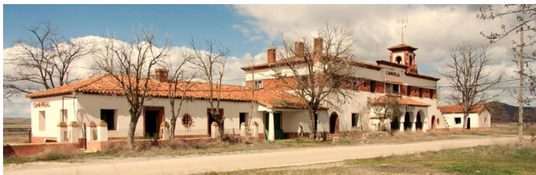
Figura 7. Estación de Caminreal. Alzado al camino. (Fuente: Colección autora, 2017)
