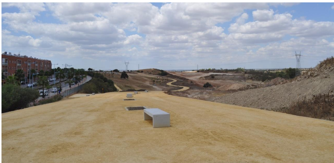
Figura 9: Franja de espacio verde en construcción junto al movimiento de tierras preparado para el paso de la SE-40 sobre la zona planificada como espacio verde, en torno al Río Culebras. Fuente: Francisco José García Fernández.
