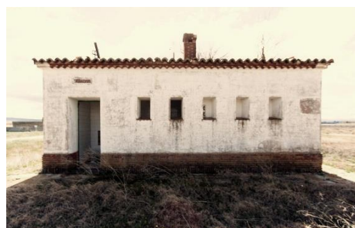
Figura 11. Estación de Caminreal. Edificio secundario de Aseos. Acceso aseos señoras (Fuente: Colección autora, 2017)
