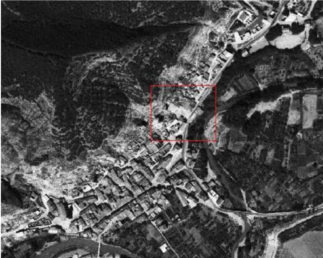
Figura 11. Ortofoto 80-86 tras el desprendimiento.
