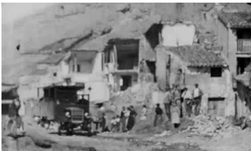
Imagen 5. Casas destruidas en 1921 en Aguilón.
