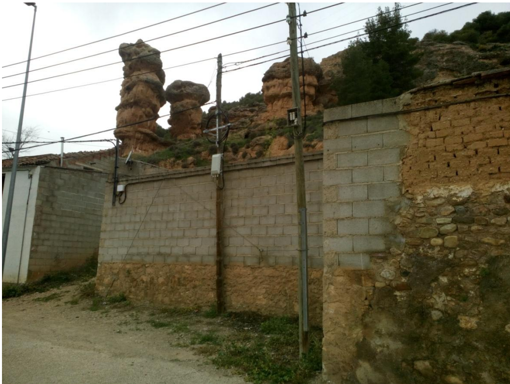
Imagen 13. Zona reconstruida tras el desprendimiento de los años 80.
