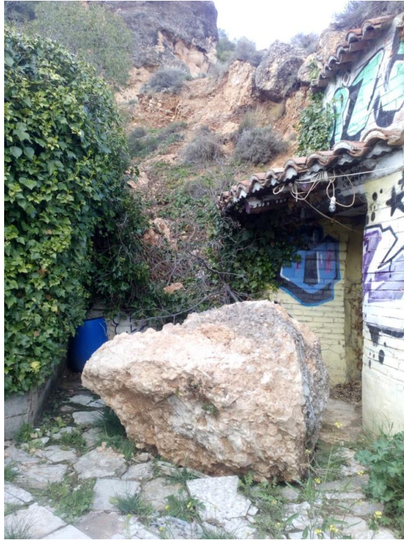
Imagen 17. Desprendimiento sobre la “Cueva de Jorge”.
