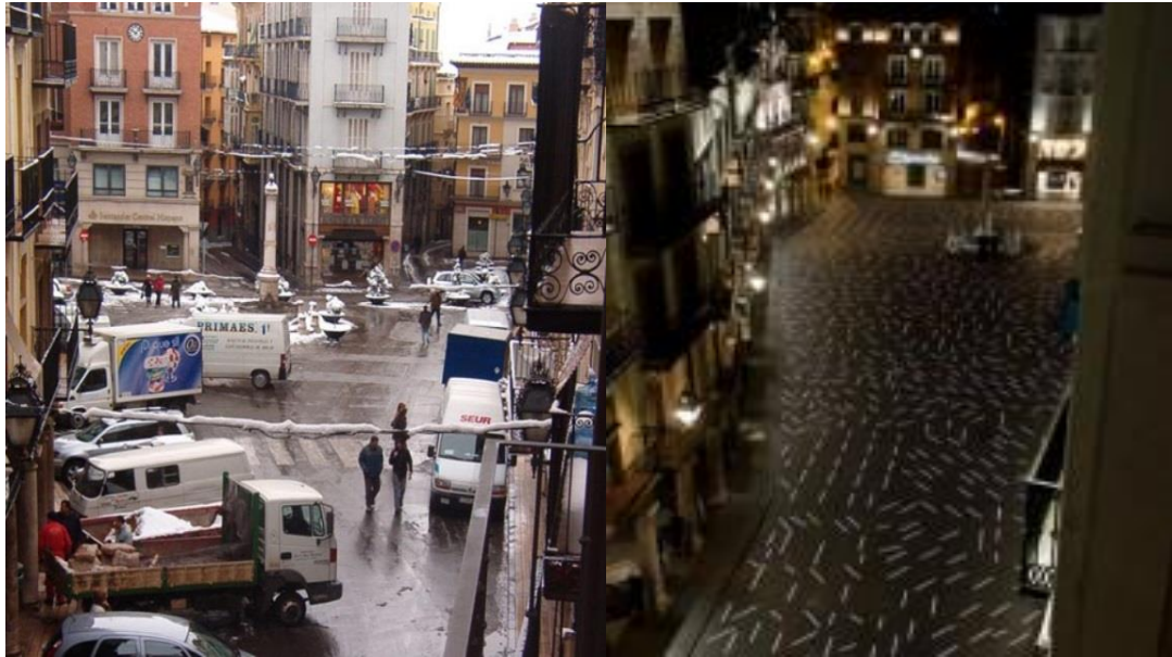
Plaza del Torico, Teruel, antes Foto n° 3 y después Foto n° 4 de la restauración.
