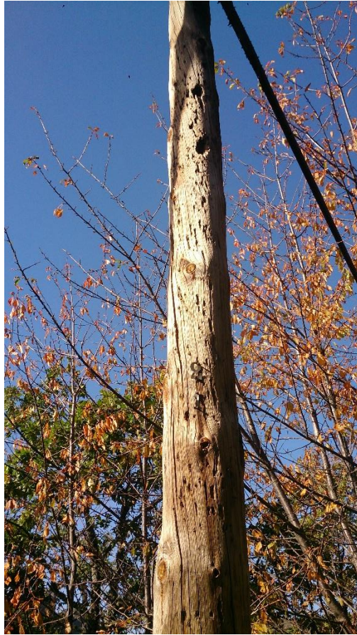
Figura 19. Daño por pájaro carpintero.
