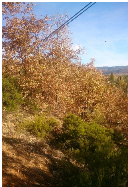
Figura 26. Vegetación sobre la línea de teléfono.
