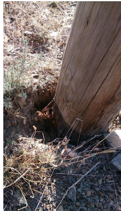
Figura 21. Base dañada.
