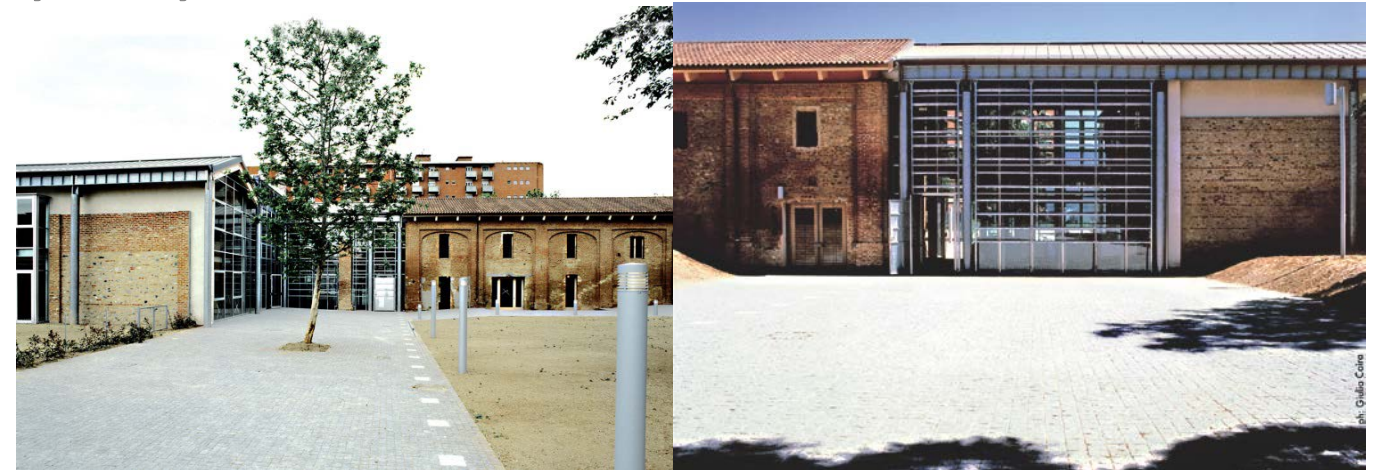
Figura 31 - Cuerpo principal de acceso, desde el interior del patio (izq.) y desde el exterior (der.).
