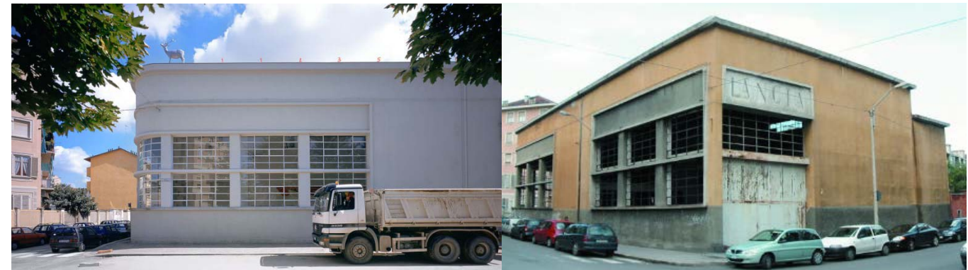
Figura 60 - Fotografía del estado exterior actual (izq.) y del exterior previo a la intervención (der.).
