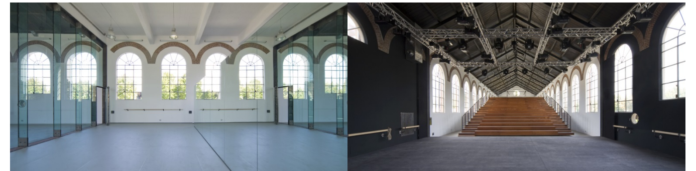
Figura 40 - Fotografías del interior de la intervención.
