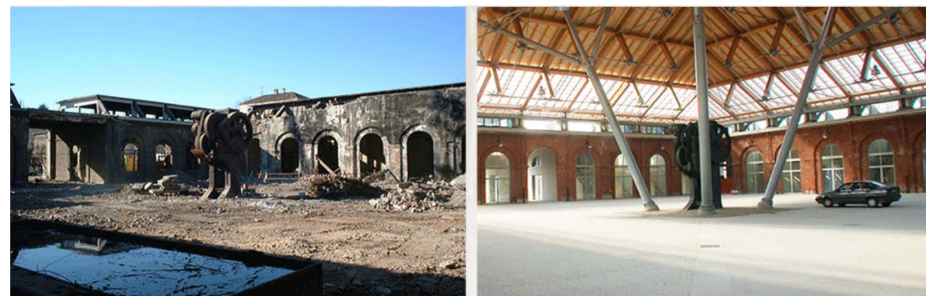
Figura 51 - Estado previo a la intervención (izq.) y una vez finalizada (der.).
