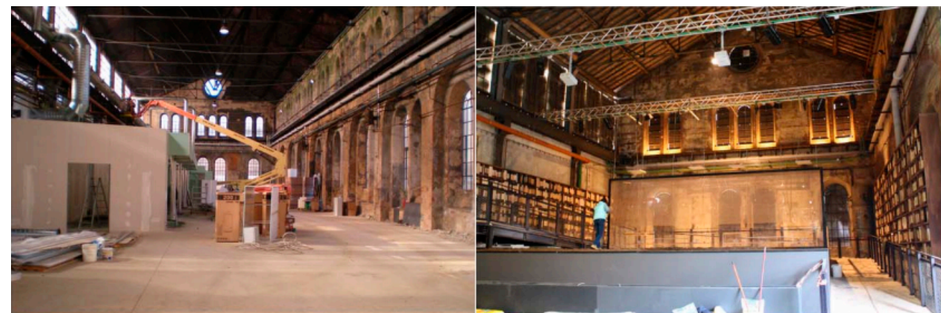
Figura 48 – Fotografía del espacio interior durante la intervención.
