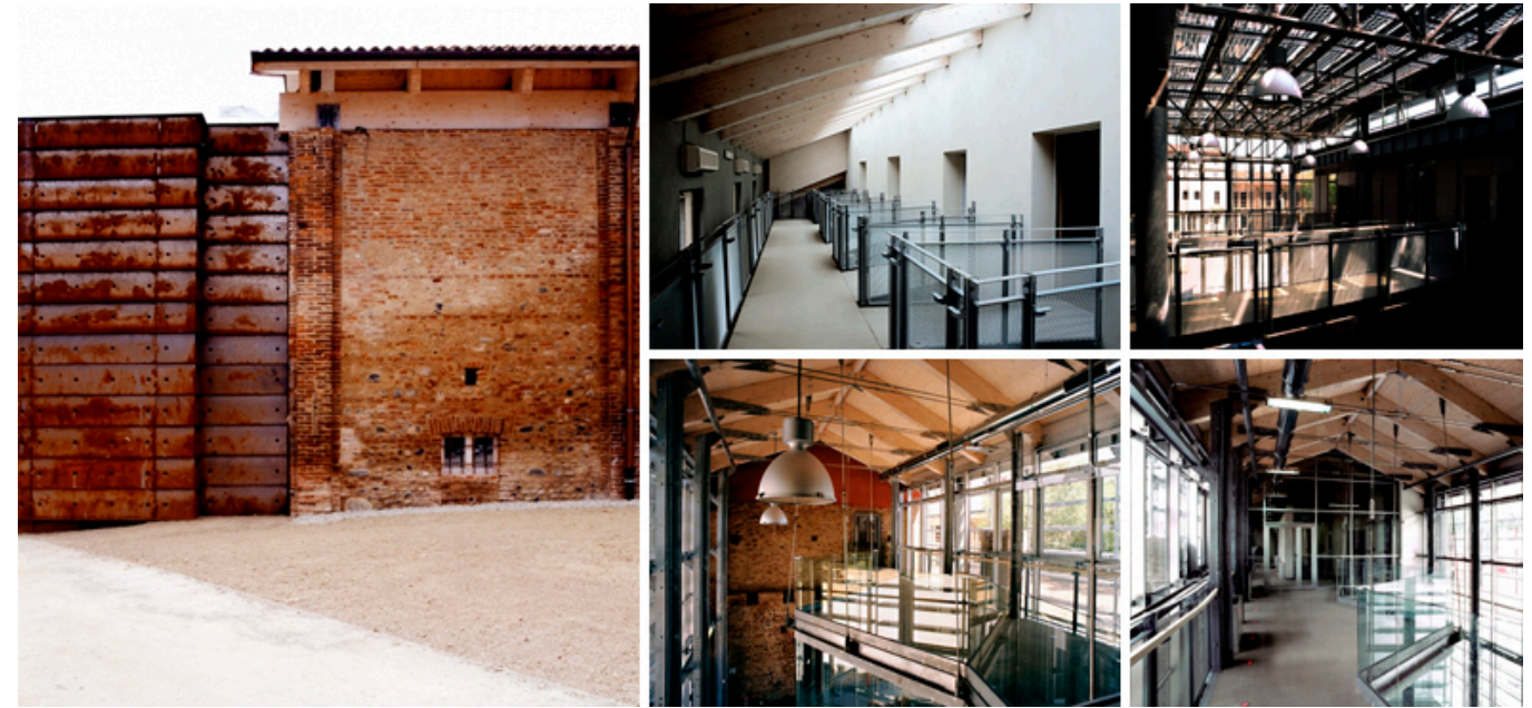
Figura 30 - Fotografías de la intervención.
