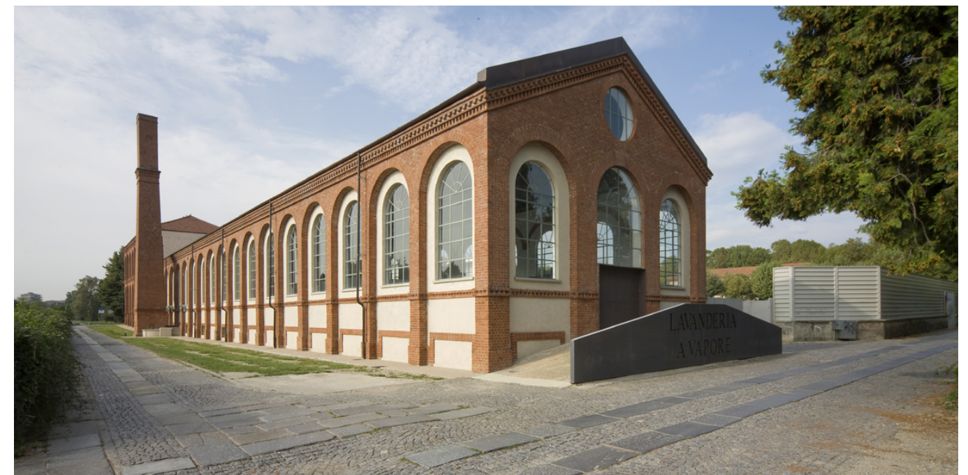
Figura 41 - Fotografía del exterior de la intervención.
