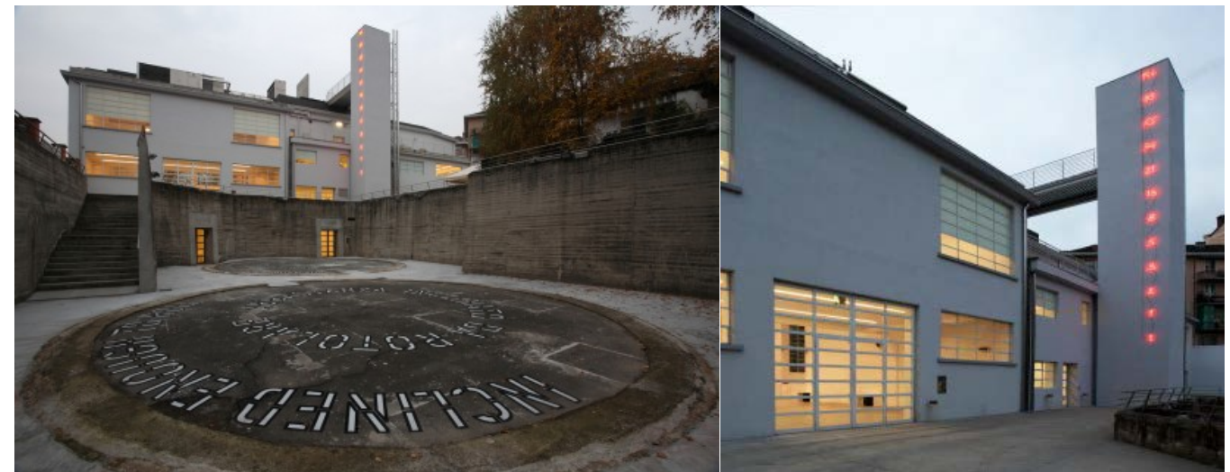
Figura 63 - Fotografías del exterior de la intervención desde el patio interior.
