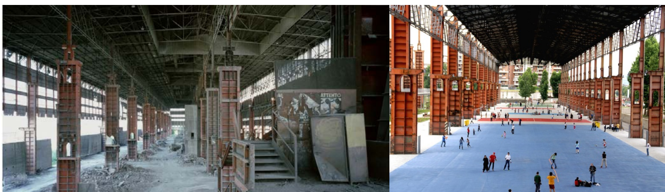
Figura 21 – Fotografía interior de Vitali antes de la intervención, 2001 (izq.) y fotografía actual (der.).
