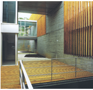
Fig 76 La intención principal de este centro del salud es el patio corrido, que se crea entre las medianeras de los vecinos, y que permite relacionar las dependencias públicas con este nuevo espacio exterior. En éste se encuentra una combinación de materiales, como las lamas verticales de madera, el hormigón de los muros medianeros con la marca del encofrado horizontal, la fachada de policarbonato, y los pavimentos de madera con otros de grava y parterres vegetales. A partir de esta relación, se enfatiza el carácter abstracto y artificial del paisaje creado.
