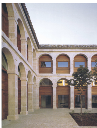
Fig 231 El mismo grupo de arquitectos intervienen en un antiguo convento para rehabilitarlo en un parador. El antiguo claustro se recupera cerrando las arcadas, mediante el retranqueo de las carpinterías de madera respecto al frente original de sillares de piedra. Esta estrategia pretende matizar la entrada de luz al interior, sin interrumpir las vistas del jardín del patio.
