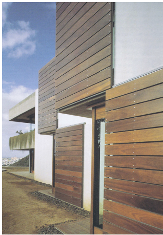
Fig 66 Estos elementos corredizos de madera cierran los balcones de los dormitorios, permitiendo configurar el aspecto de la casa según el momento del día.
