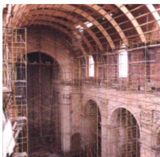
Fig 7. Reconstrucción de la iglesia de Medina de Rioseco, Valladolid. Vista interior de la construcción de la bóveda de madera laminada.
