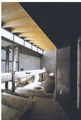
Fig 230 Esta intervención realizada por Aranguren & Gallegos, aloja el museo del vino de la rehabilitada casa del Maestro Almeda. Tras consolidar los muros existentes, el espacio se cierra mediante una cubierta formada por vigas de madera de pino laminada y sobre ésta, se dispone un trasdós interior de paneles de contrachapado. La nueva cubierta queda sujeta mediante unos pilares de acero cortén. La elección de los materiales pretenden enfatizar la construcción de las antiguas arquitecturas dedicadas a la producción del vino, ya sea por las tonalidades de los propios materiales, como por las soluciones constructivas tradicionales.
