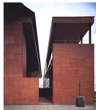
Fig 9. Pabellón de Castilla-La-Mancha (Expo de Sevilla, 1992). Vista exterior de la envolvente formada por tableros de madera.
