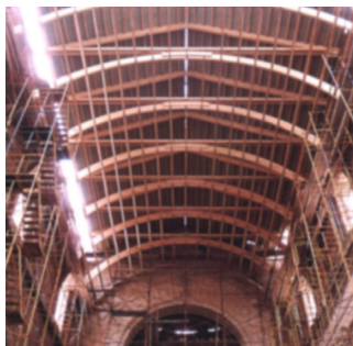
Fig 6. Reconstrucción de la iglesia de Medina de Rioseco, Valladolid. Vista interior de la construcción de la bóveda de madera laminada.
