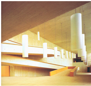
Fig 95 Las luminarias colgantes y la madera, que reviste los suelos, las paredes y el pasamanos de la rampa, otorgan un contrapunto cálido a la textura rugosa de los elementos estructurales de hormigón blanco.
