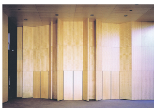
Fig 86 Otro ejemplo que asume la cualidad plástica de la madera, se hace visible en el acceso a la sala del teatro. A modo de biombo de madera de sicomoro, configura la entrada al presentarse como un elemento singular dentro del propio vestíbulo, que invita a los espectadores a cruzarlo, y presenciar así la función.
