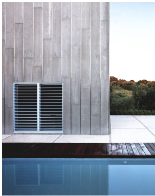
Fig 141 Esta vivienda situada en el barrio de las Rozas, se presenta como una ambigüedad entre la construcción tectónica y la cabaña. Ábalos y Herreros construyen esta casa mediante una estructura prefabricada de acero y un revestimiento invertido, acabado con tableros de madera-cemento.
