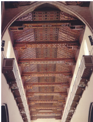
Fig 3. Techumbre de la catedral, Teruel. Vista interior de la techumbre de madera.
