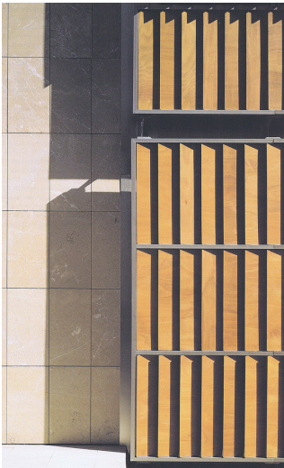
Fig 77 El uso de celosías de madera puede jugar un papel adicional a la protección solar, al ponerse en relación con otros materiales. La madera empleada en las celosías y en los cuerpos de comunicación se combina con las fachadas de piedra caliza y el acero inoxidable de las naves, que expresan la pluralidad de funciones que el centro posee.
