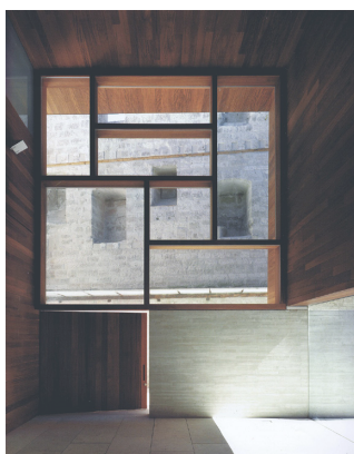
Fig 87 La textura del encofrado horizontal del hormigón se pone en relación con el revestimiento interior de tablas de madera de iroko; contraste de la tonalidad oscura de la madera y la clara del hormigón.
