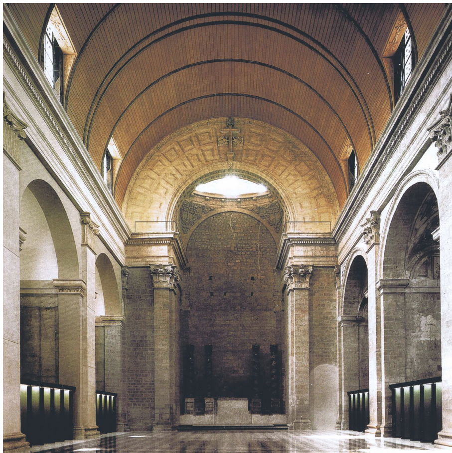
Fig 4. Reconstrucción de la iglesia de Medina de Rioseco (Valladolid), vista interior de la nave.
