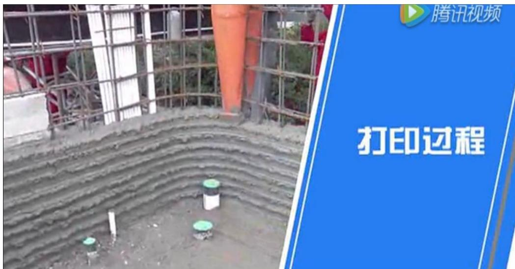
*Ilustración 54 - Impresión sobre armadura*
