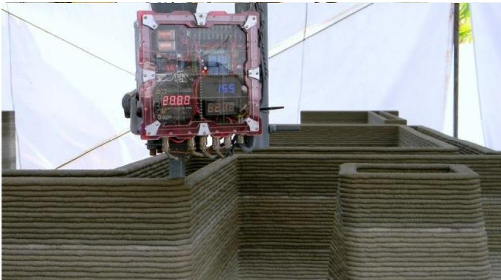
*Ilustración 43 - Máquina impresora*
