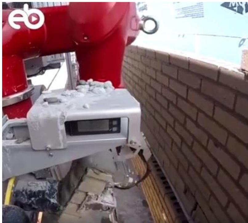
*Ilustración 56 - Máquina que coloca el ladrillo aplicándole mortero*
