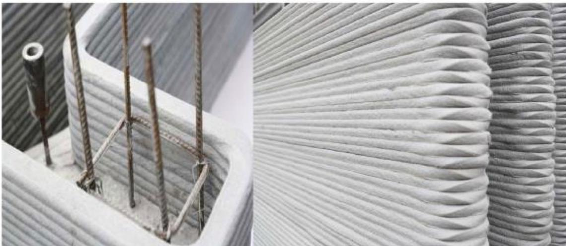
*Ilustración 28 - Muro hueco para armar*
