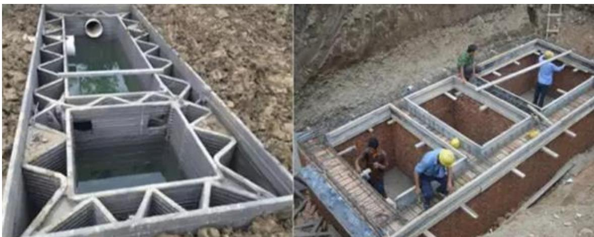
*Ilustración 61 - Saneamiento inferior prefabricado*
