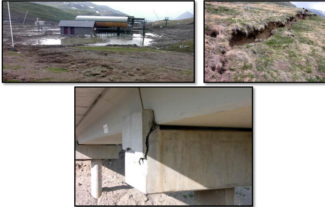
Figuras 2, 3 y 4. Repercusiones de las obras realizadas en las ampliaciones de la estación.
