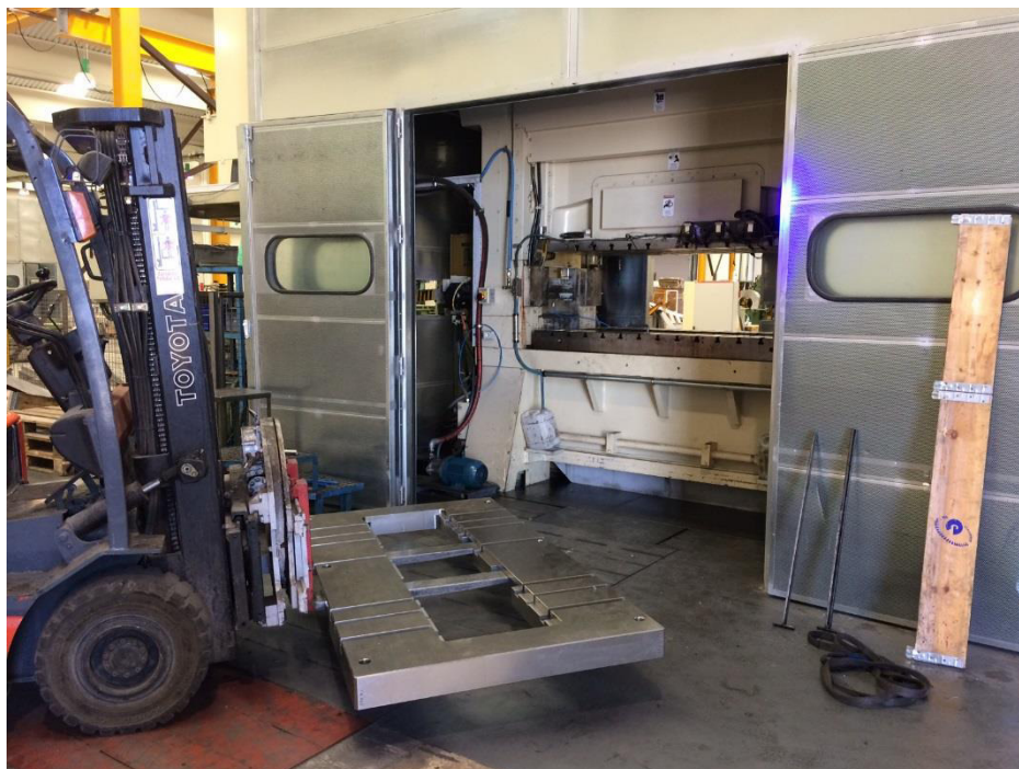
Imagen 16: Montaje nueva bancada E107
