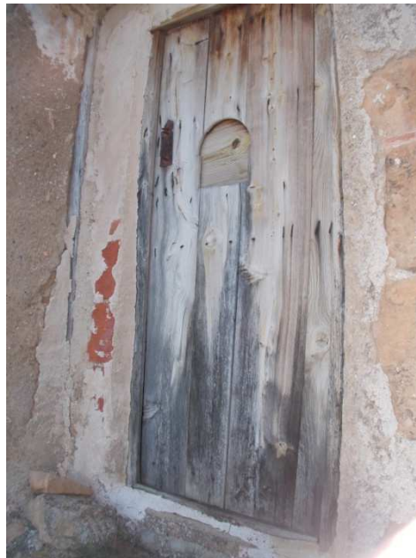
Ilustración 91: Puerta acceso almacén.
