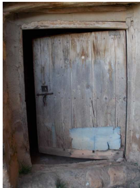
Ilustración 90: Puerta acceso corrales.
