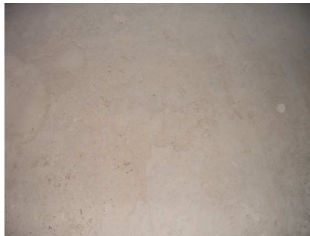
Ilustración 88: Revestimiento de mortero.
