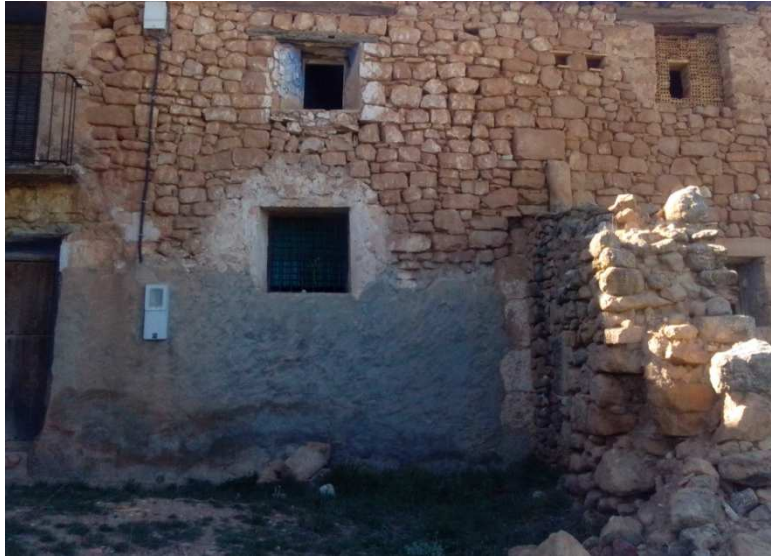
Ilustración 82: Revestimiento fachada principal.
