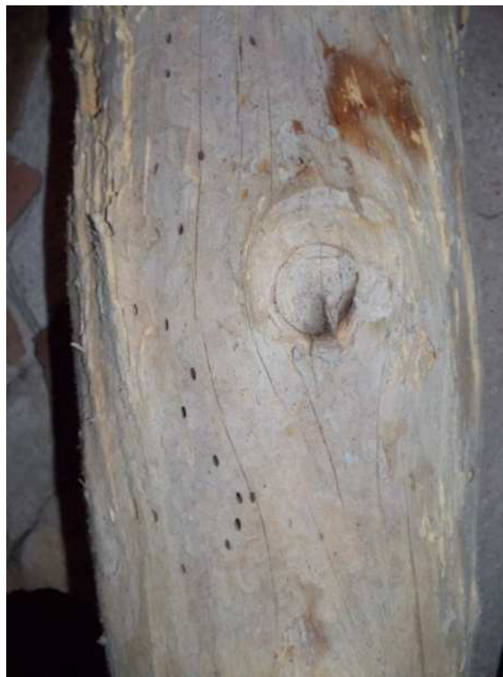
Ilustración 65: Forjado con ataque de insectos.
