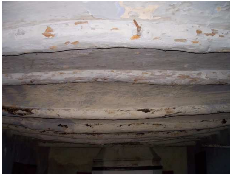
Ilustración 64: Forjado flechado.
