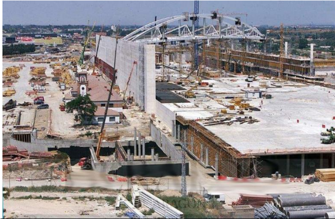
2000, construcción de la Estación Intermodal Delicias
