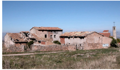
Fig. 31 Construcción agroganadera en canto rodado. La Unión de los Tres Ejércitos.
