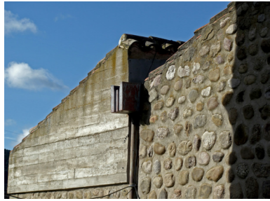
Fig. 71 Detalle del canalón. Templo de Santiago. La Unión. Gerardo Cuadra. 1965.
