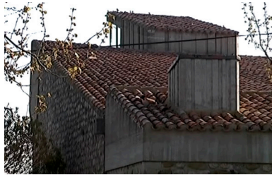
Fig. 49 Expresividad del hormigón. Lucernarios templo de Santiago. La Unión. Gerardo Cuadra. 1965.
