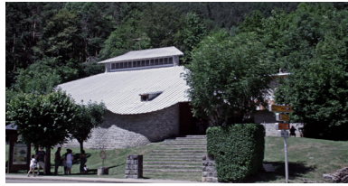
Fig. 56 Lucernario del baptisterio. Iglesia de Nuestra Señora del Pilar. Canfranc. Miguel Fisac. 1965.
