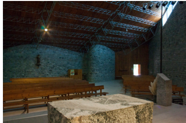
Fig. 77 Cubierta ligera. Iglesia de Nuestra Señora del Pilar. Canfranc. Miguel Fisac. 1965.
