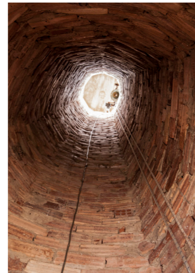
Fig. 74 Interior de la torre del templo de Santiago. La Unión. Gerardo Cuadra. 1965.
