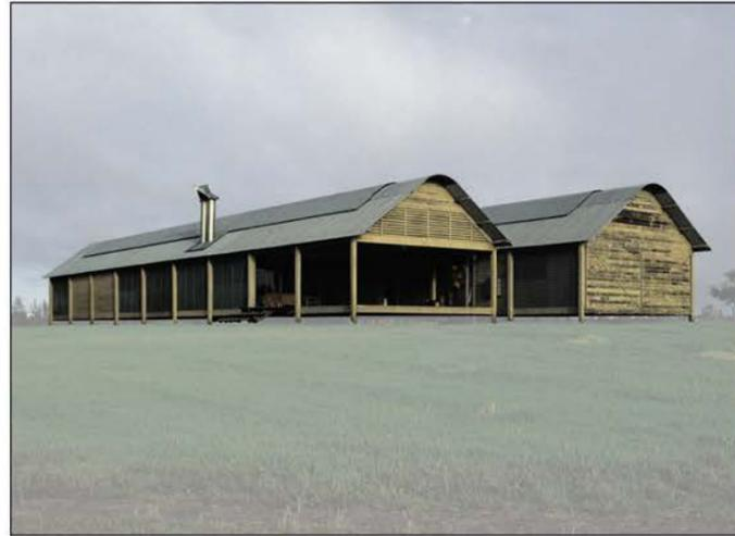
La superposición de una sobrecubierta curva solapada con la cubierta a dos aguas procura un mecanismo de ventilación al mismo tiempo que rompe la escala de la propia cubierta. Esta fue la primera vez que utilice una cubierta curva. Ofrece una buena circulación de aire, con una óptima presión negativa a sotavento en ambos lados de la cubierta. El aire fresco es succionado hacia el interior del edificio. [...]
