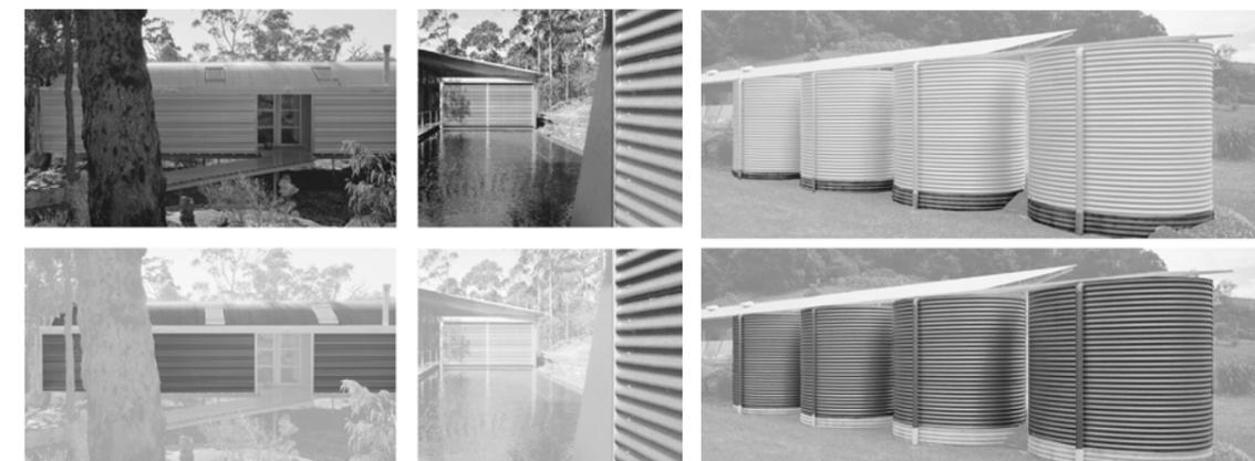
Casa Ball Eastaway, completamente recubierta de chapa en distintas direcciones de onda según su misión.
