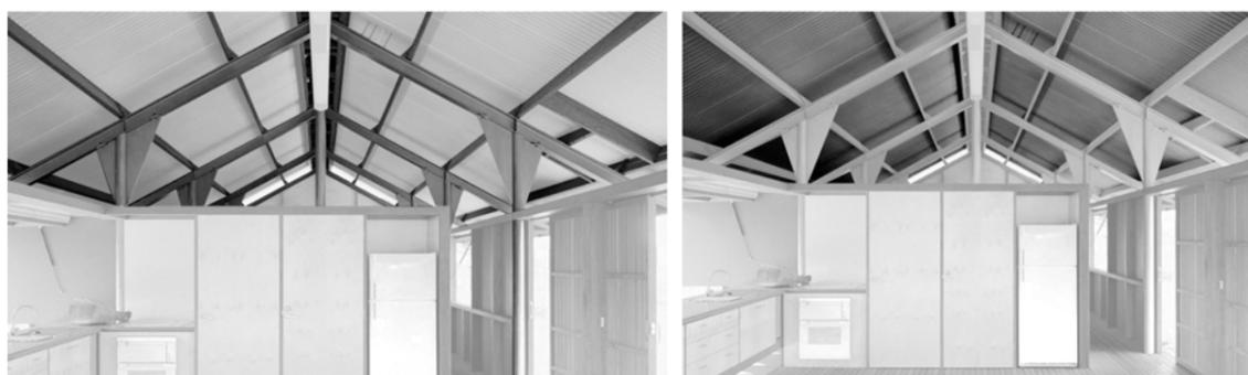
Se puede observar como la casa es la estructura que soporta la cubierta y ésta, todos los elementos están prefabricados y es una mezcla entre madera y acero. Todo lo no estructural es madera y su materialidad es vista.
