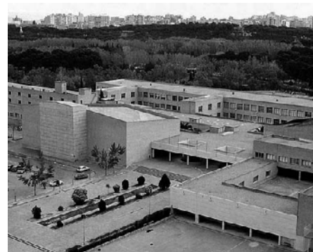
24. Exteriormente el ladrillo era el elemento que envolvía todo el volumen de la iglesia; actualmente se ha recubierto todo con enfoscados.
