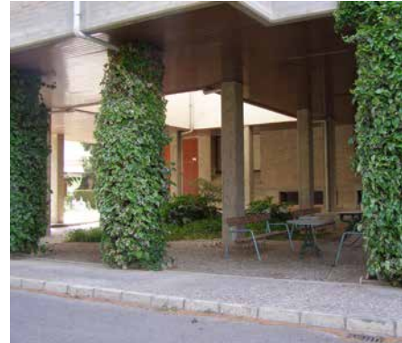
37. El claustro que se menciona finalmente no se llegó a construir. Aparece en los planos visados del archivo pero no en los planos del estado actual proporcionados por los arquitectos que llevaron a cabo la reforma
