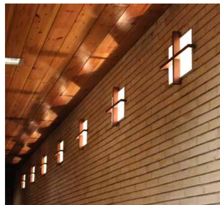
f[61 y 62] Fotografías actuales del hall de entrada al Colegio Infantil Jesús Reparador.
