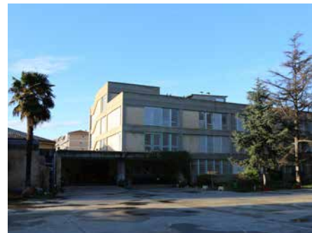
f[126] Fotografía actual de la fachada del edificio de las Hermanas Salesianas en Vía Ibérica, Zaragoza.
