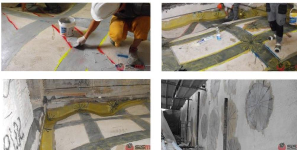
Colocación de la fibra de carbono en diferentes elementos
