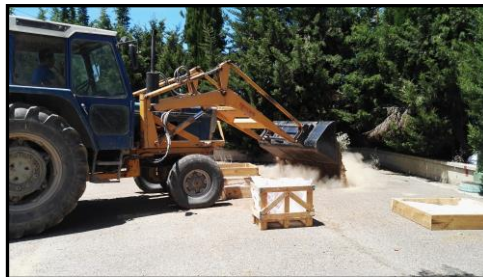
Figura 5.4.1.5.: Pala excavadora depositando tierra en el colegio.
