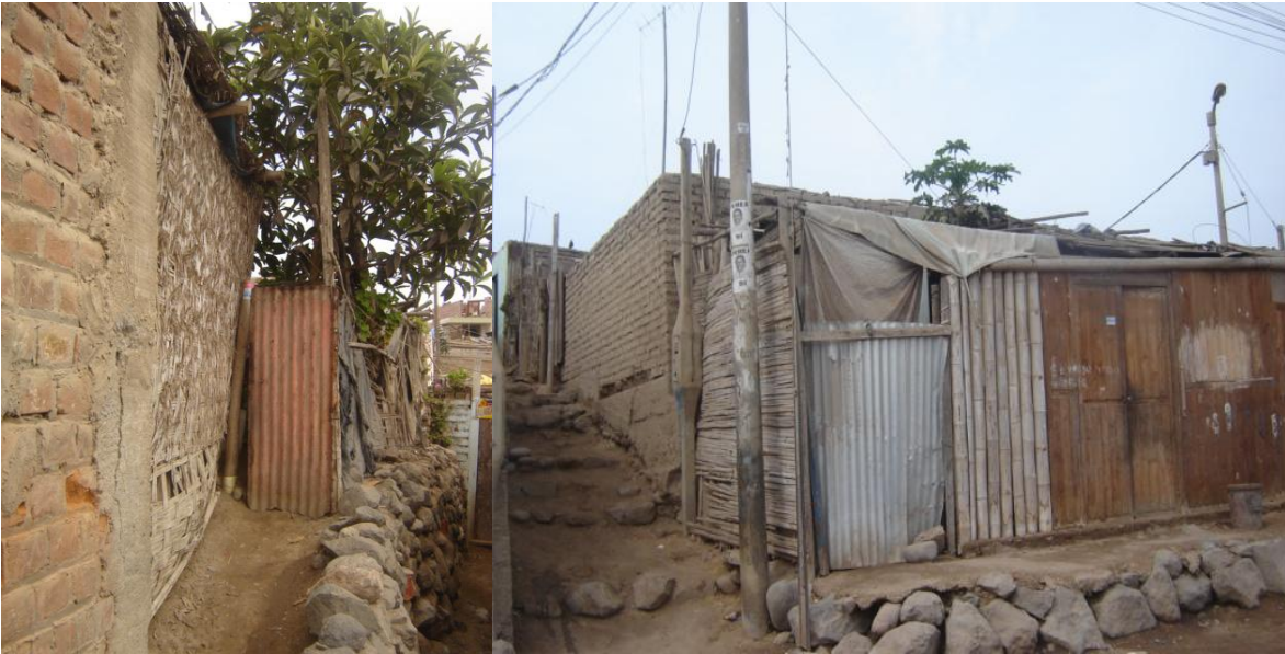
Imagen 8: Construcción de estera (izquierda) y construcción de madera y bambú (derecha).
