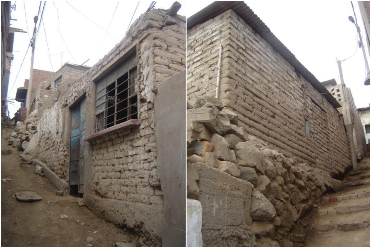
Imagen 12: Construcciones asentadas sobre una pendiente de en torno al 35^\circ en el cerro de San Cristóbal.
