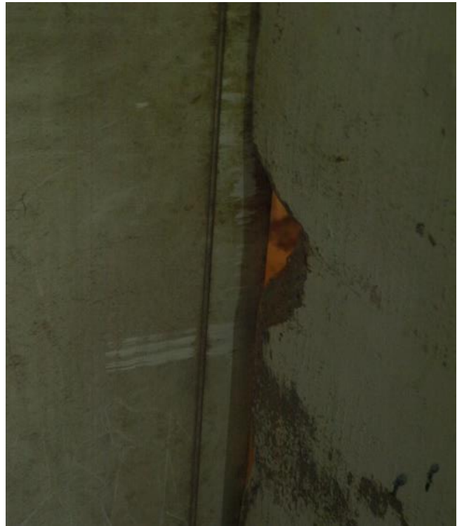
Figura 18. Entrada parásita de aire.
