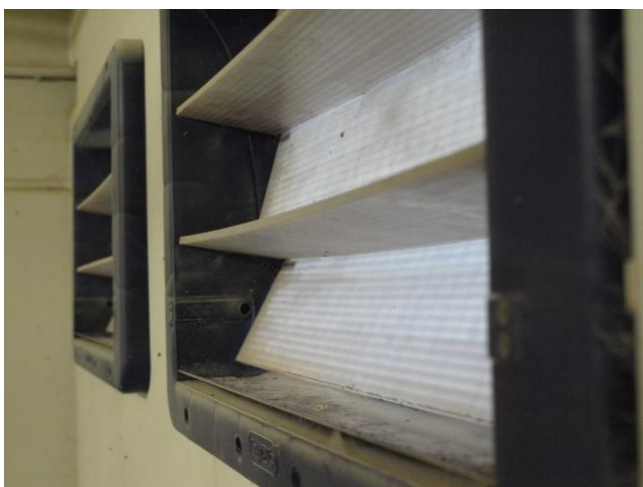
Figura 11. Sección de entrada de aire en una de las ventanas de la sala.
