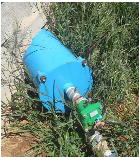
Figura 1. Filtro de malla actual con válvula para limpieza
