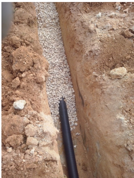
Ilustración 2. Imágenes de los drenajes instalados
